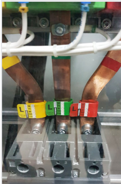
Пример установки газовыделяющих наклеек
