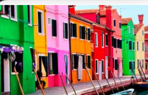
Строительство и ремонт
